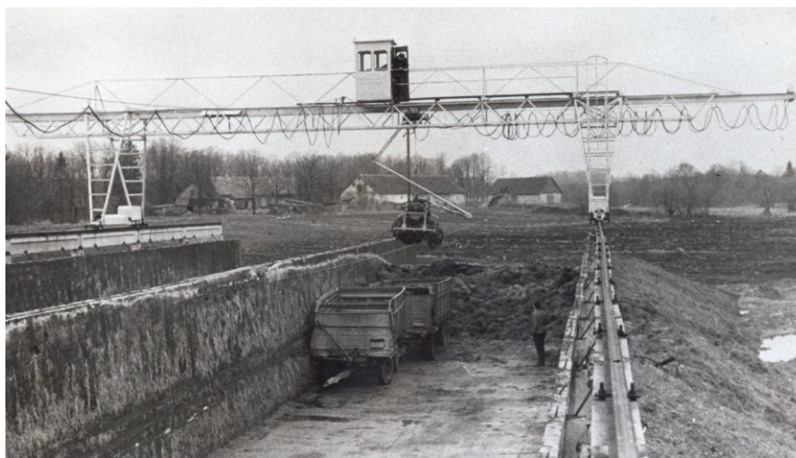
8.1. att. Tranšejas ar mobilu pa sliedēm pārvietojamu buka celtni un greifera iekārtu PG-1,7 skābsiena masas iekraušanai un izkraušanai, arī tvirto kūstmēslu kraušanai un kompostēšanai. Autori: Edgars Lāčgalvis un Haralds Kurzemnieks, a.a. 433038 (~ 1970).
