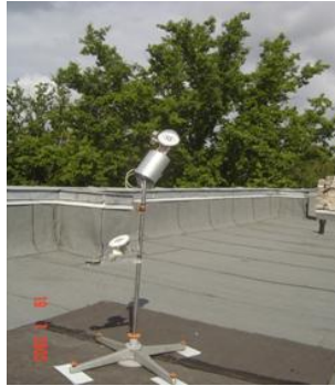
10.3.att. Ierīce MD-4 uz ēkas jumta
