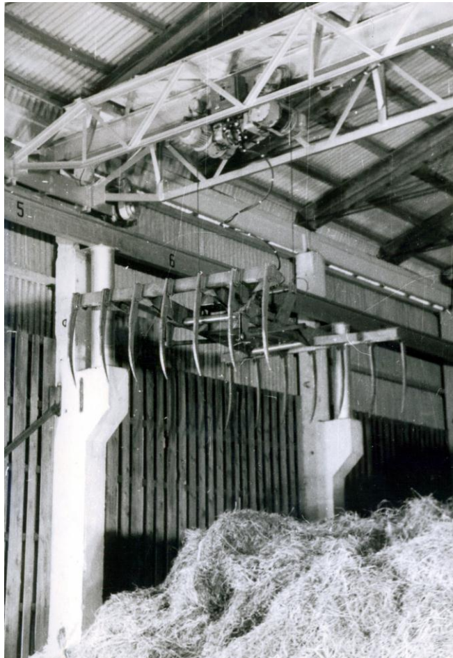
15.1. att. Siena šķūnis ar tilta krānu un greifera tipa siena krāvēju (~1998)
