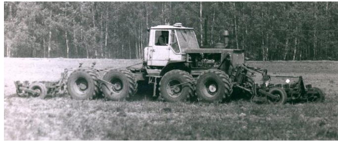
20.2. att. 8 riteņu traktors T-150K-8 ar visiem velkošiem riteņiem un priekšējo uzkari augsnes apstrādē (1988).
