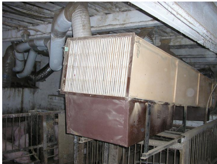
10.9. att. Eksperimentālā siltummaiņa izmēģināšana ražošanas apstākļos 500 nobarojamo cūku kūtī (2004).
