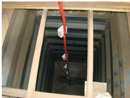
3.6. att. Caurules ar sensoriem novietojums graudu tvertnē.
