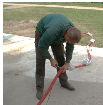
3.4. att. Sensoru montāža uz caurules.
