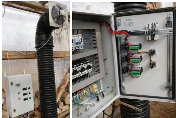
7.3.2.att. Automatizētas siltumnīcas ventilācijas (apsildes/dzesēšanas) sistēmas vadības bloks, eksperimentālajā siltumnīcā (50kvm) zs “Skudriņas”
