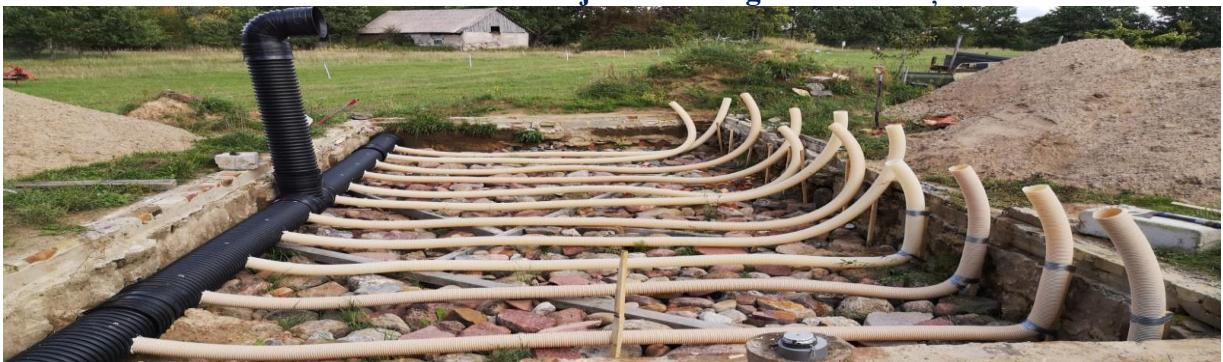
7.2.5. att. Siltumnīcas akumulācijas 100 mm gofrēto cauruļu izvietojums
